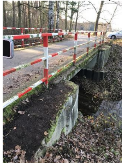
HK – 046 - most přes Stříbrný potok – za chatovou oblastí – odstranění humózní zeminy
