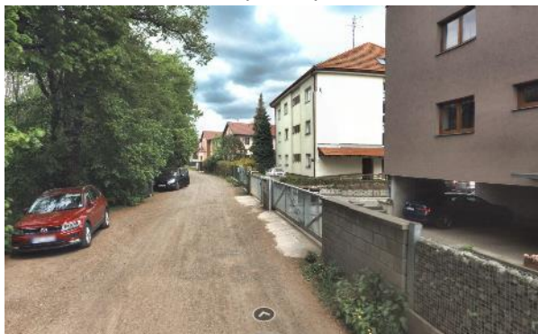
Ul. Zámostí – před opravou
