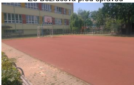
ZŠ Bezručova před opravou
