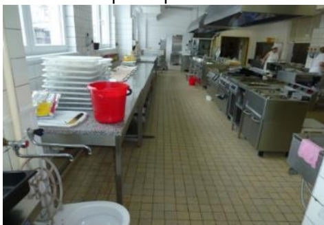
Stav před opravou
