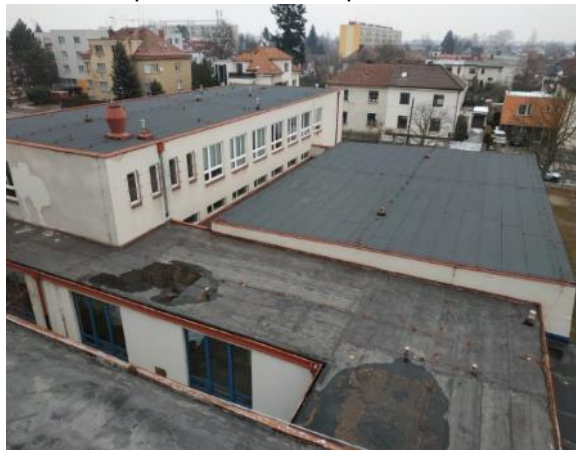
Foto před stavebními úpravami
