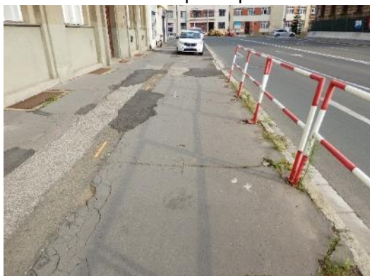
Ulice Divišova před opravou
