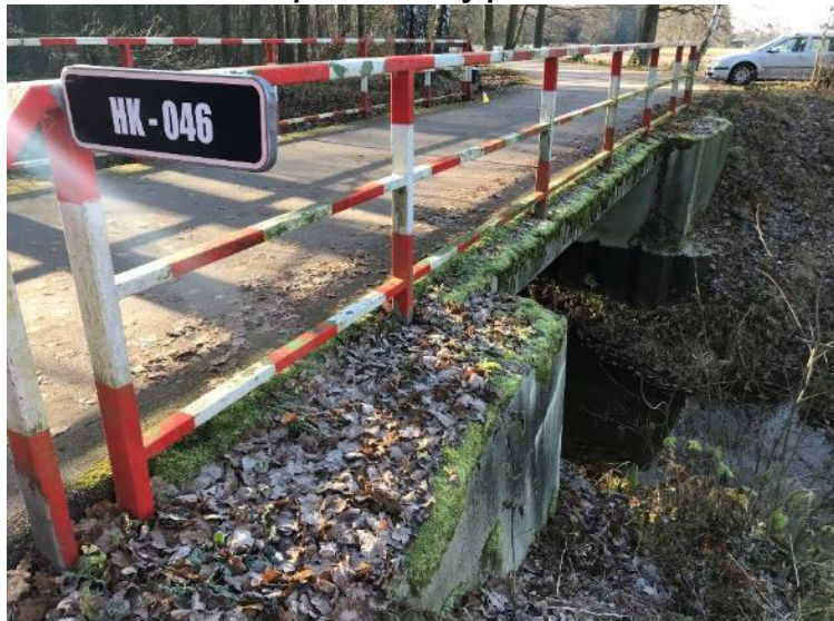
HK – 046 - most přes Stříbrný potok – za chatovou oblastí – odstranění humózní zeminy
